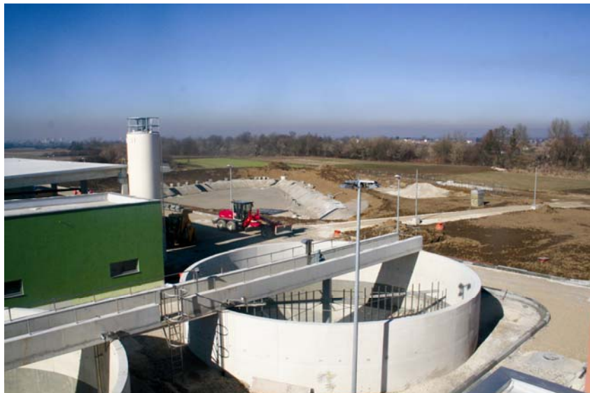
Naknadni zgušnjivač mulja i umjetno jezero u pozadini
