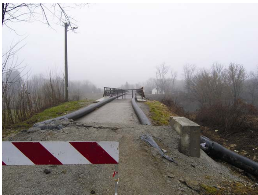
Privremeni spoj ( bypass ) za odvodnju preko Drvenog mosta na Korani
