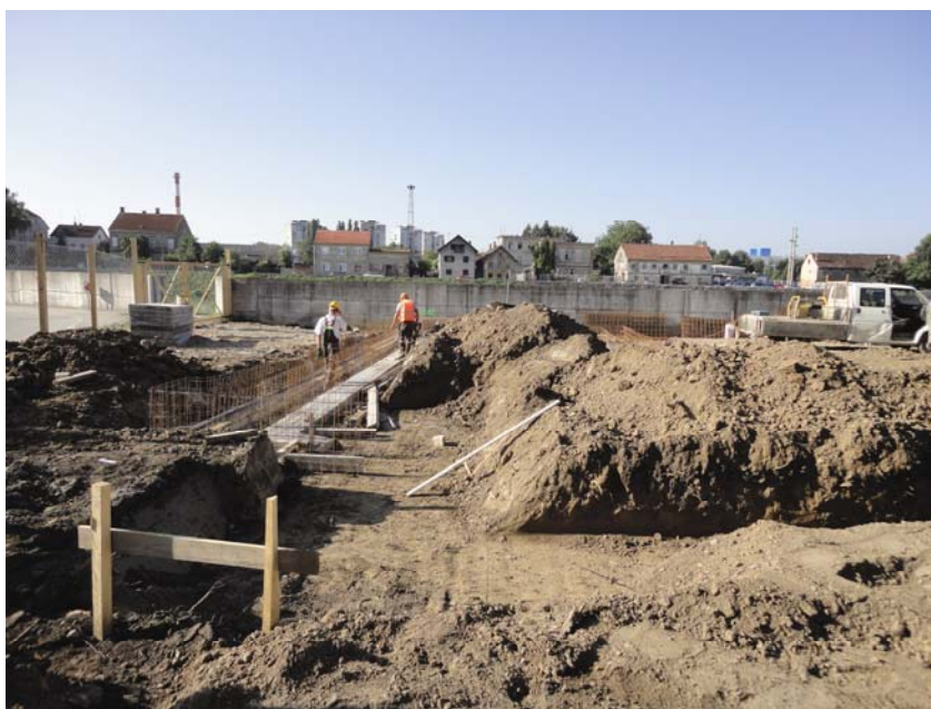
Početni radovi na crpnoj stanici Drežnik
