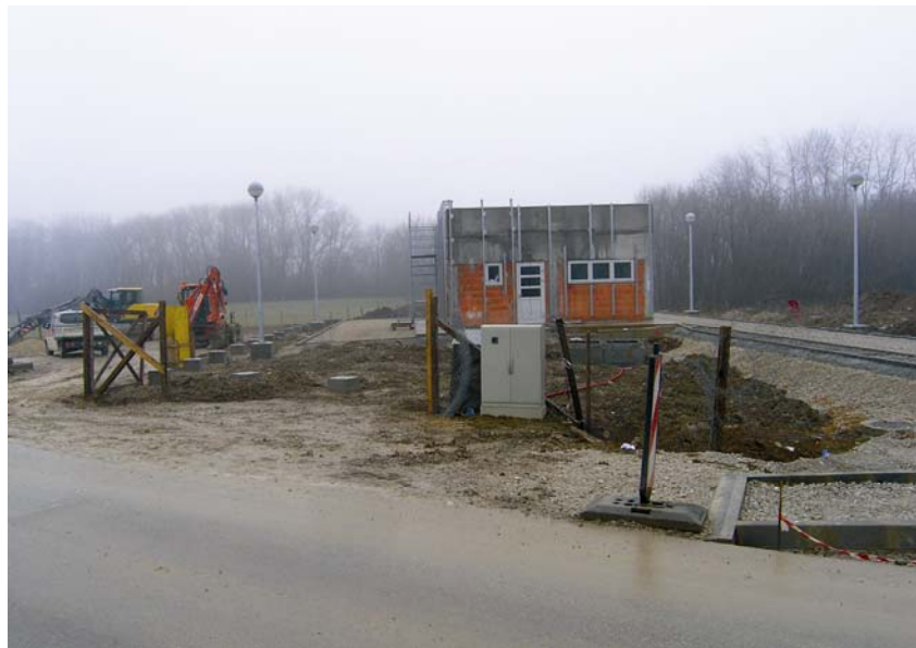
Radovi na crpnoj stanici Grad
