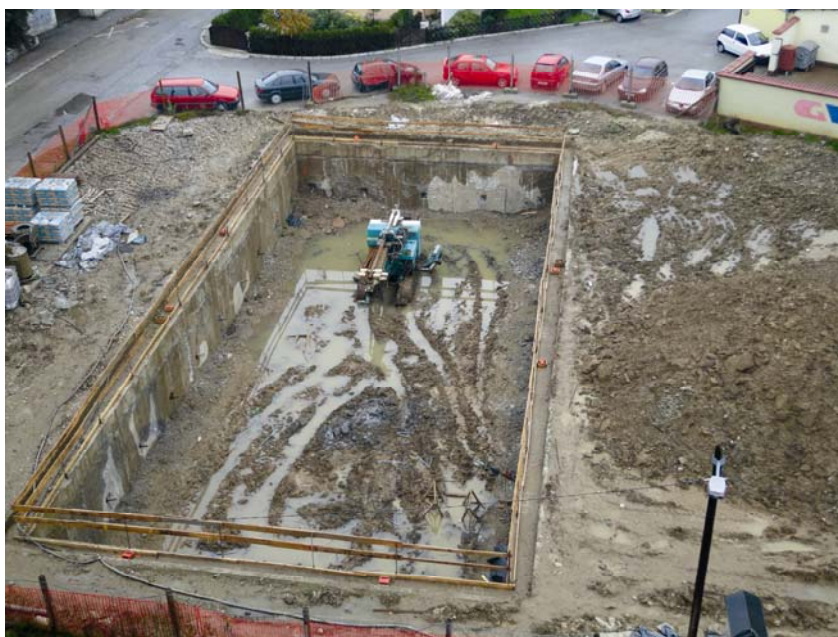
Zaštita građevne jame na crpnoj stanici Gaza
